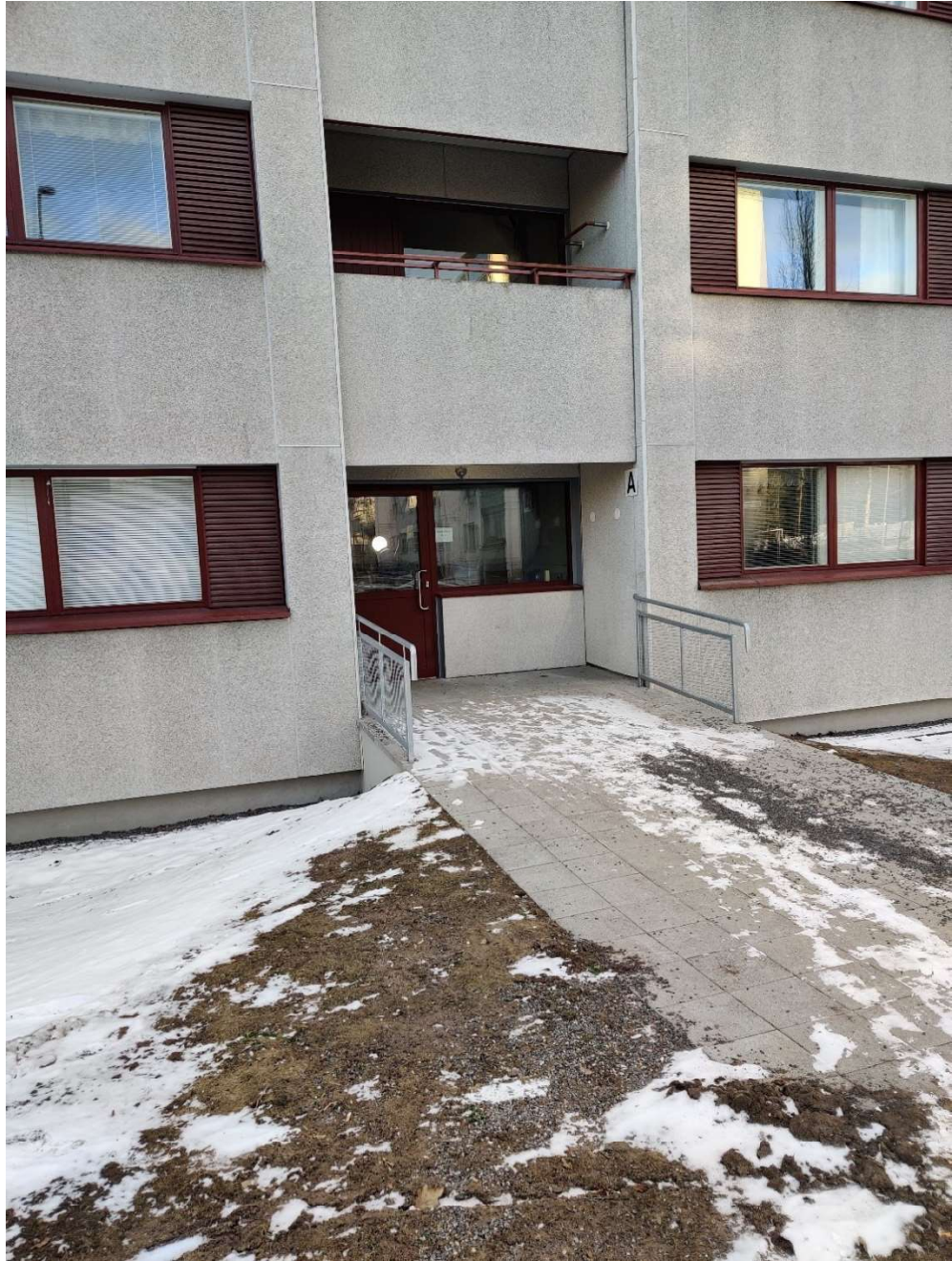
Kuva 12. A-portaan uusi esteetön sisäänkäynti.
