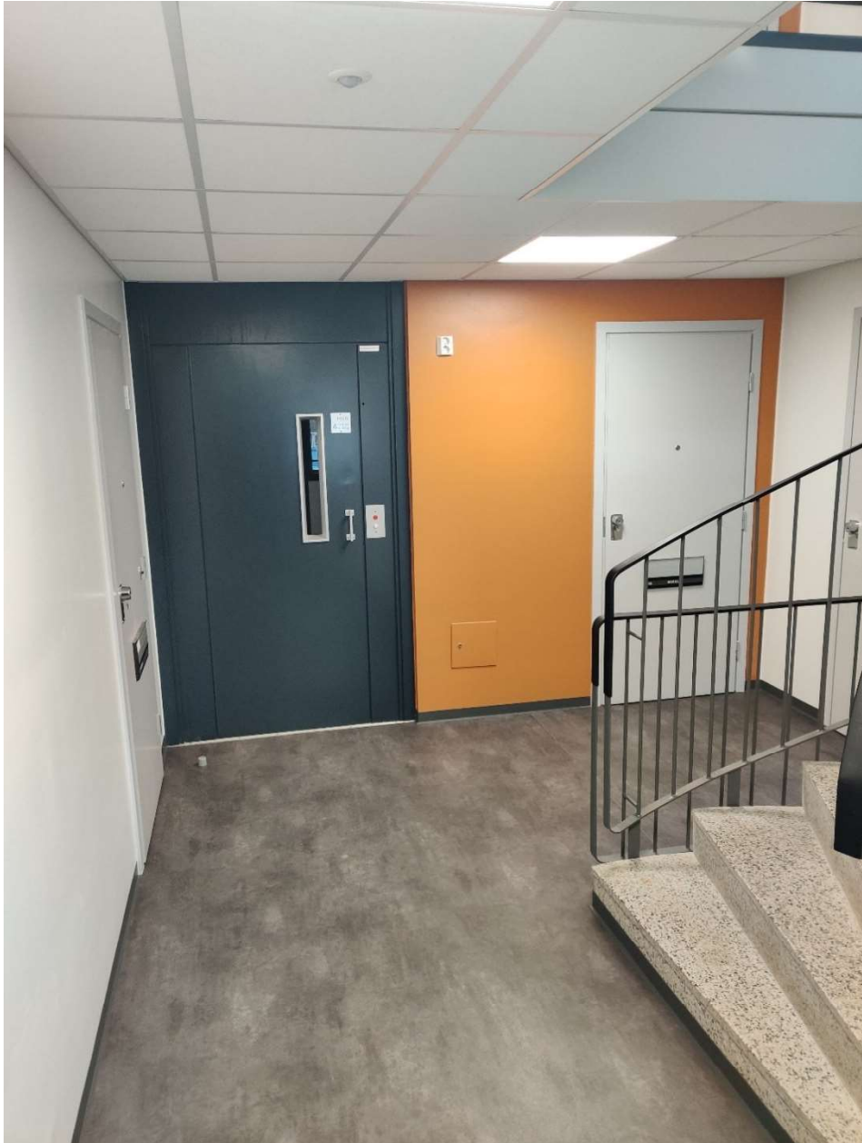
Kuva 10. D-portaan uusittu 2. kerros.
